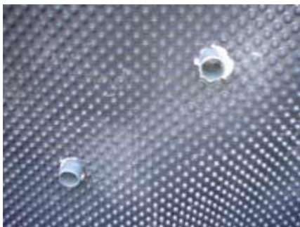
Montera platonmattan innan rören ansluts till inbyggnadsdelarna.
