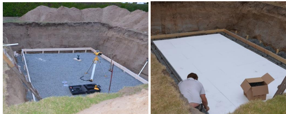
Dräneringslager, gjutform och bottenisolering.
